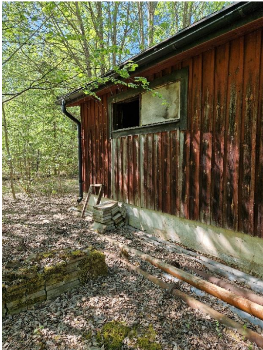
Figur 5. Storgruvschaktets (St1) överbyggnad.
