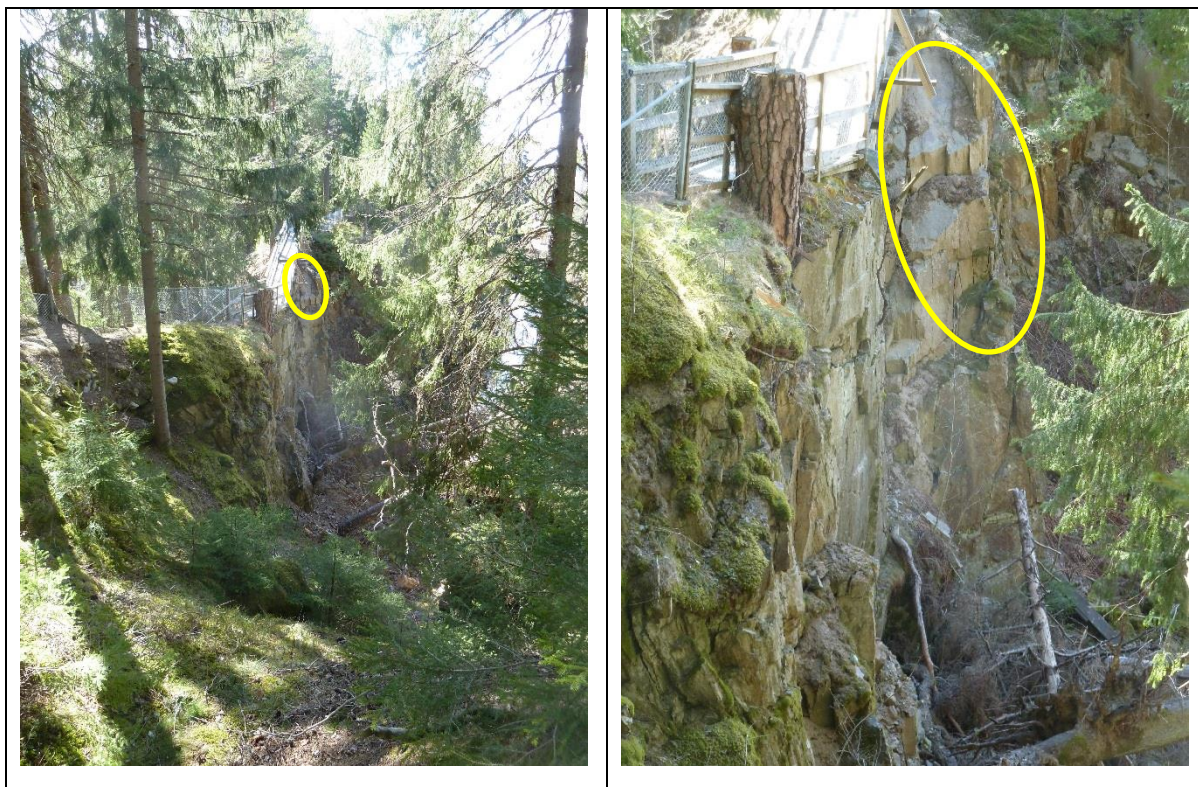
Figur 11. Bron i Mossgruvsparken. Inringat område markerar tidigare inte dokumenterat rasområde på norra sidan av mellersta brostödet.
