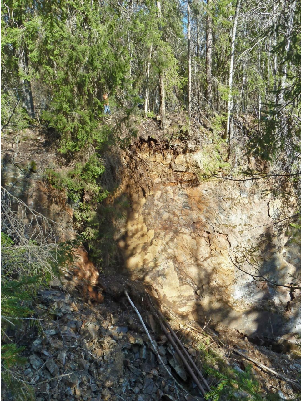
Figur 16. Rasområde i norra väggen av Klackbergs dolomitbrott (färskt rasområde har något mörkare brun färg). 2020-04-16. Notera person i blå byxor på promenadväg i övre delen av bilden.
