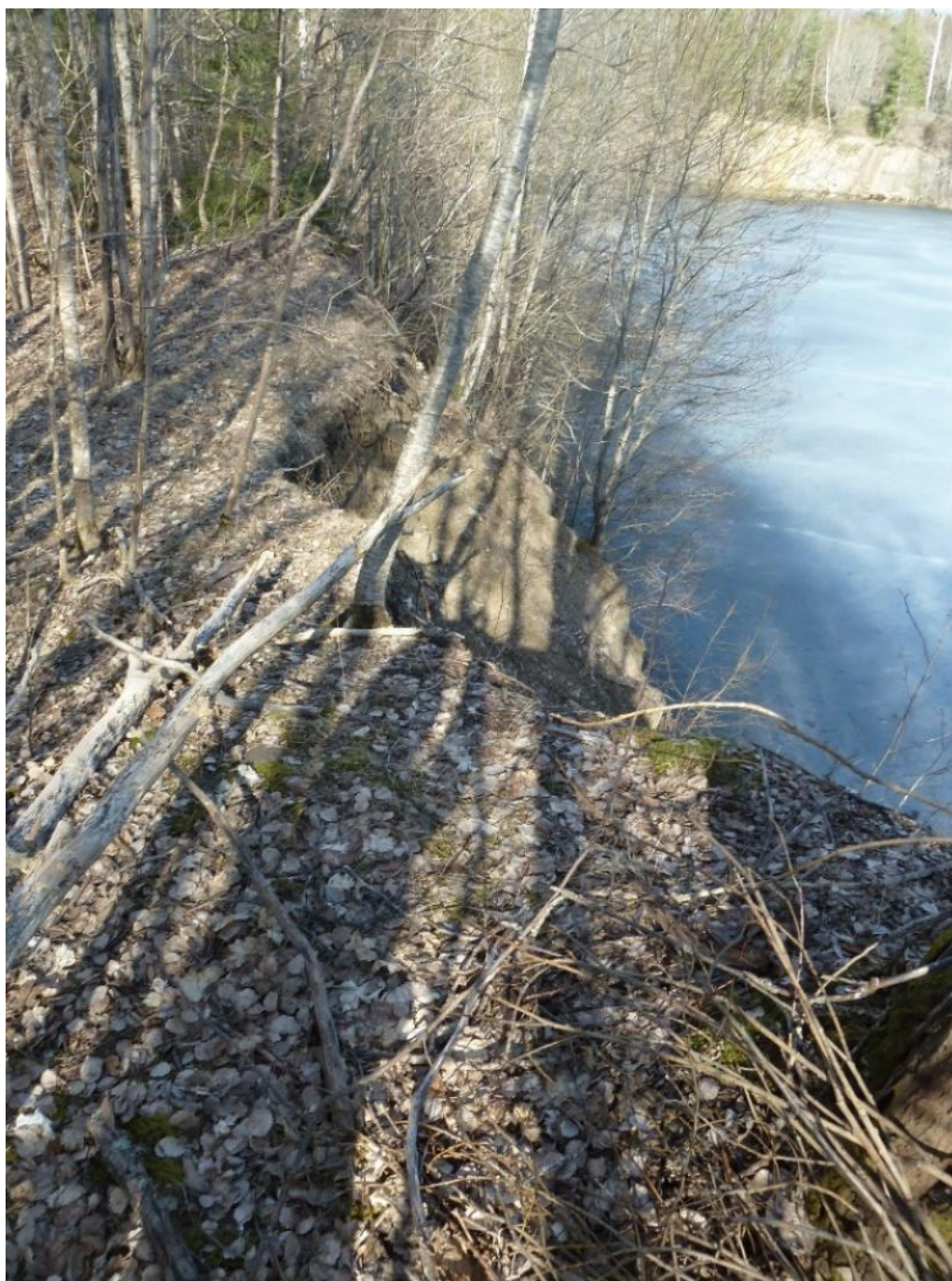
Figur 7. Nytt ras våren 2020 i västra väggen av Spettalet inom område S4. Rasområdet var tidigare aktivt i perioden 1982 till 2015 och har då en yta av drygt 1250 m 2 . Våren 2020 har ytan ökat med 150 m 2 . (2020-04-16).
