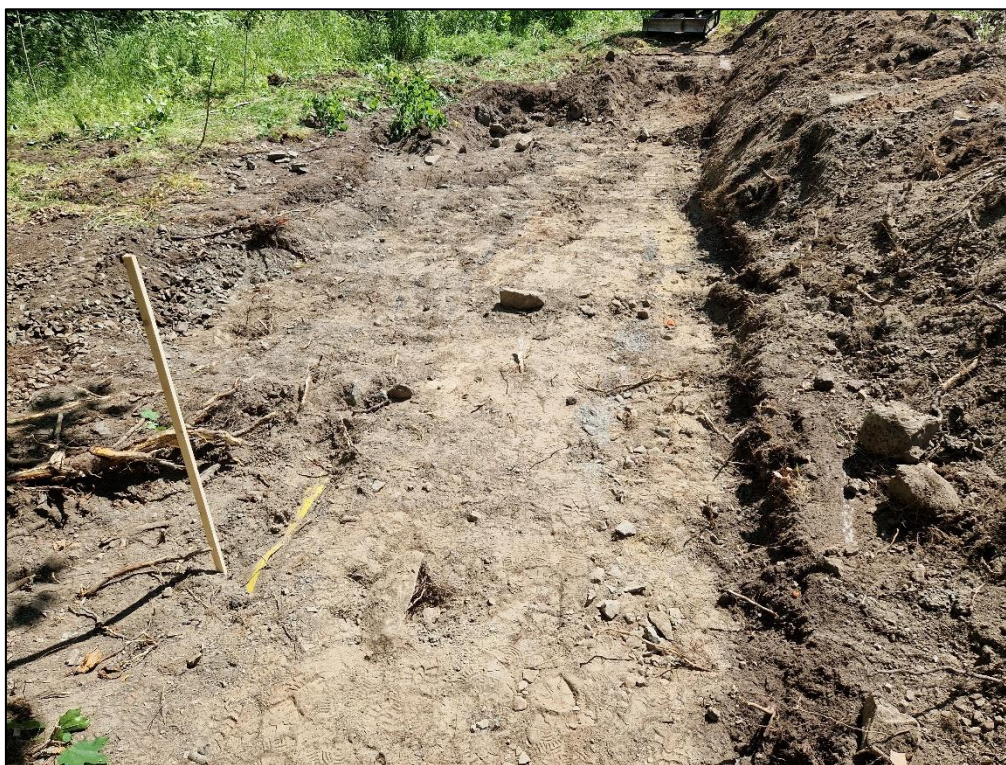
Figur 5. Del av avschaktad yta sedd mot söder.
