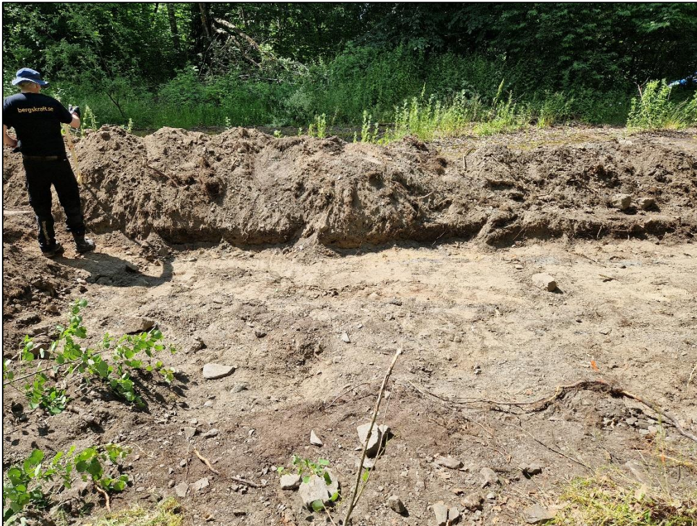
Figur 4. Del av avschaktad yta sedd mot väster.
