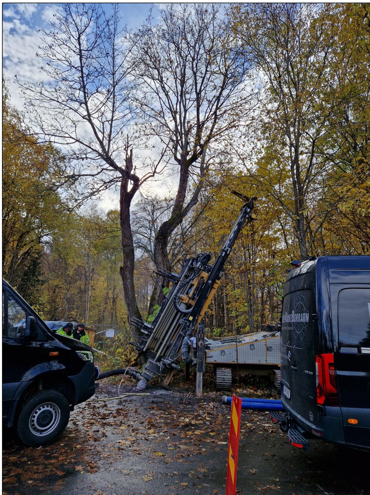
Figur 6. Borrhning av I3B med 165 mm diameter den 14 oktober 2024, 62° lutning mot riktning 129°.
