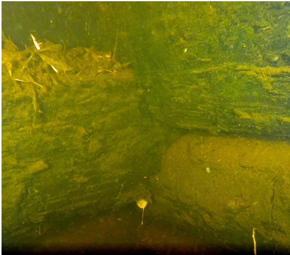
Figur 10. Liggande timmer sammanfogade i nordöstra hörnet (GH0501170 @ 08:52: --)
