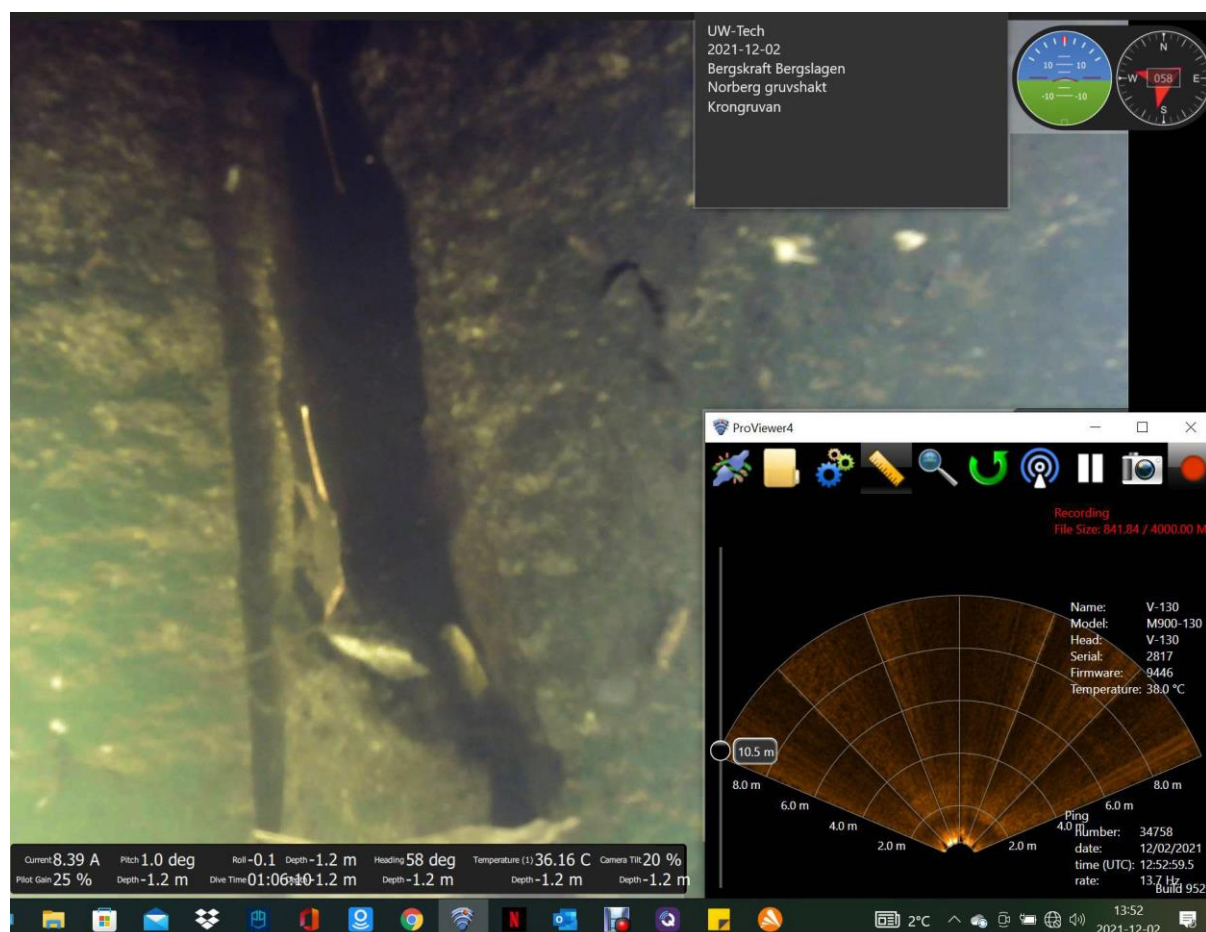
Figur 12. Borrpipa i stenblock i kallmuren på nordöstra sidan av schaktet på 1,2 m djup.
