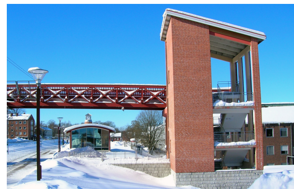
Gångbron mot Koppardalen och tågstoppet.
