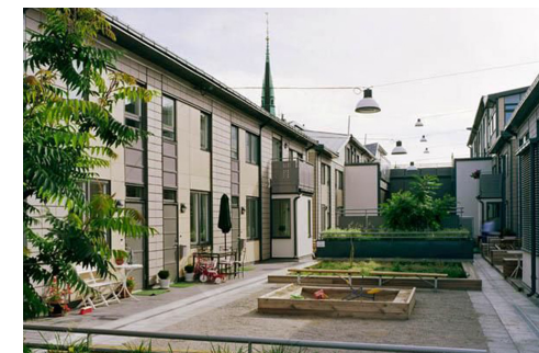
Innergård vid påbyggnad med bostäder på befintlig byggnad (Stockholm)
