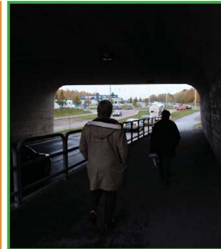
Viadukten under järnvägen behöver bli bättre och mer omsorgsfullt belyst
