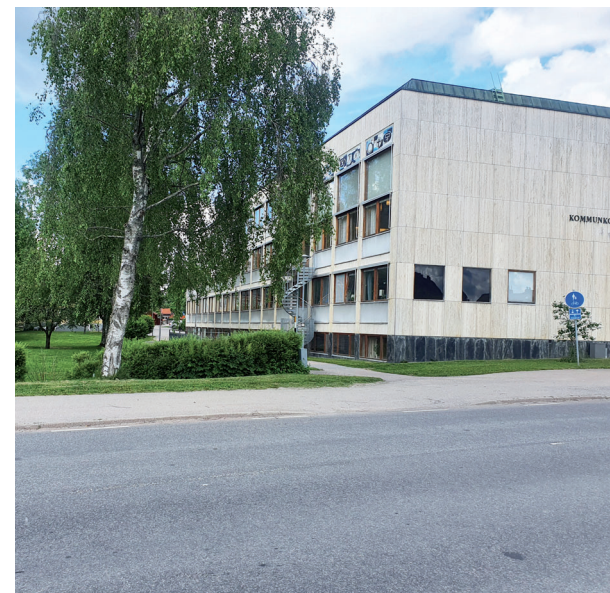
Söder om kommunhuset saknas passage/övergångsställe. WSP 2022.
