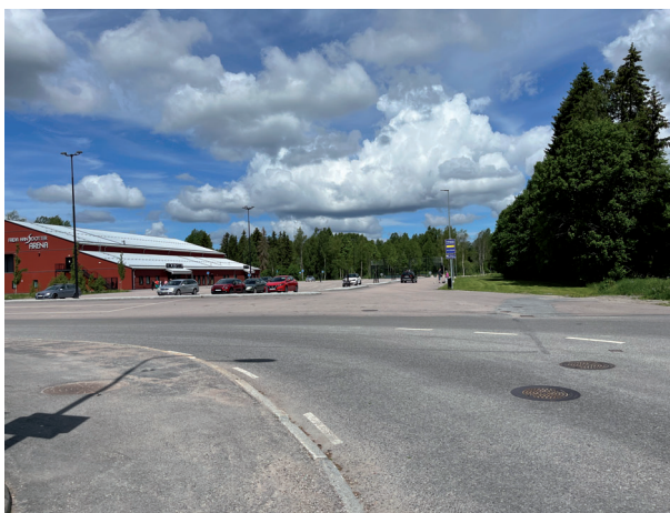
Otydlig trafiksituation i korsningen Esbjörnsvägen/Fagerstavägen. WSP 2022.
