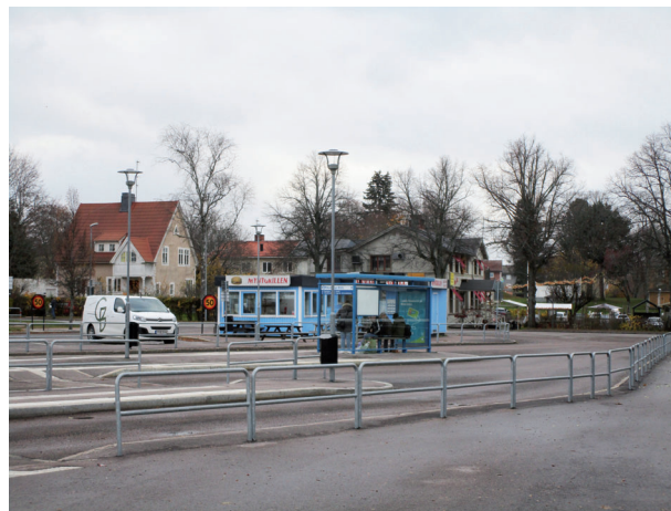
Befintlig utformning på busstorget, med rörräcken och ledstråk. Detaljutformningen på konstgjorda ledstråk bör ses över.
