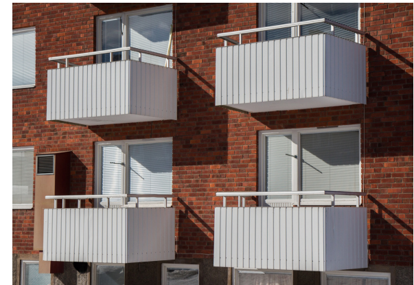
Ursprunglig storlek har behållits men balkongerna har försetts med nytt räcke.
