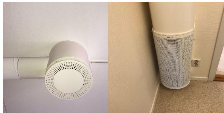
Två exempel på tilluftsdon. Takmonterat tilluftsdon samt deplacerat tilluftsdon.
