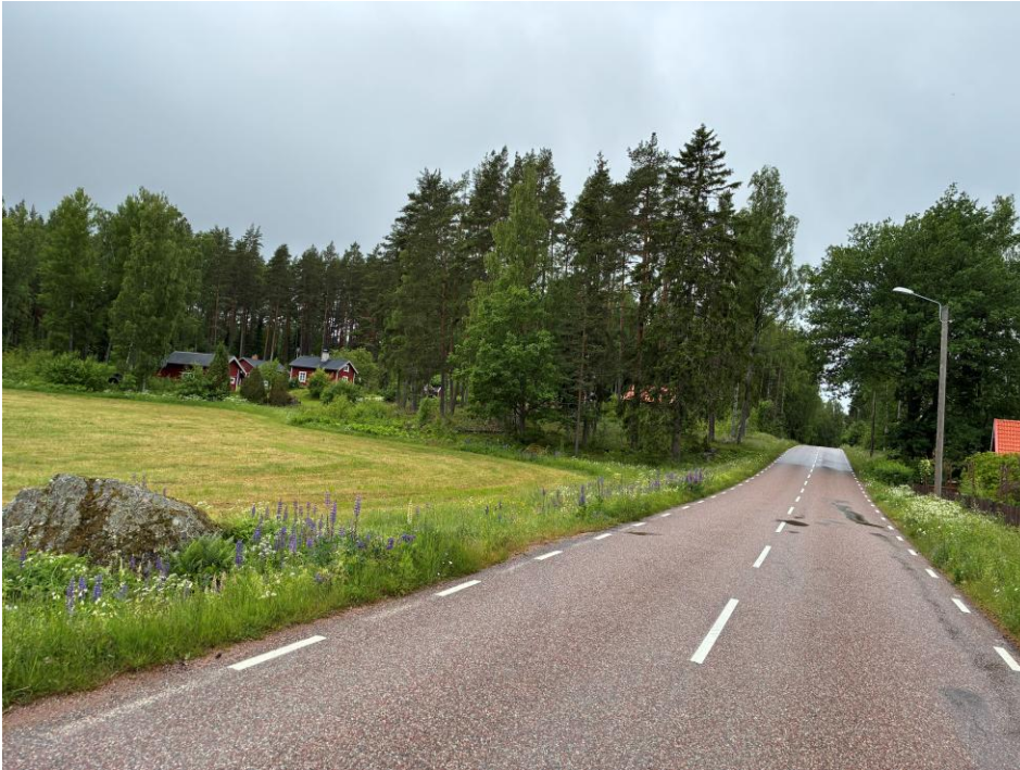
Figur 13. Dagvatten från genomfartsvägen (väg 705) och mindre grusvägar i området rinner av mot vägdiken och naturmark.
