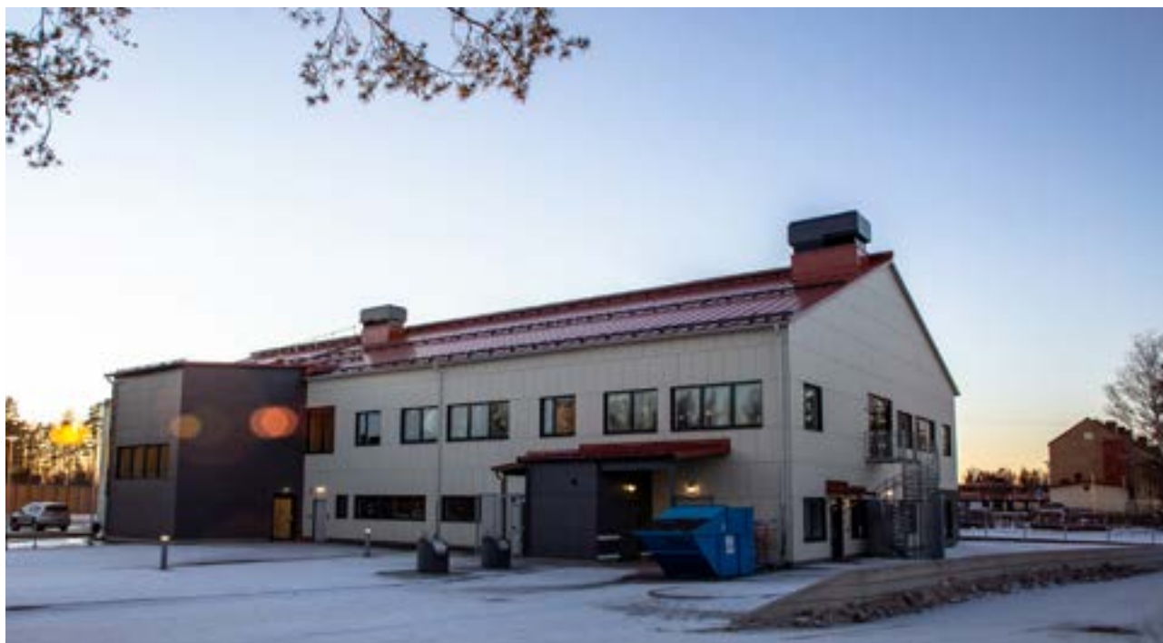
Skogsbo Skolas nya byggnad med både klassrum och matsal
